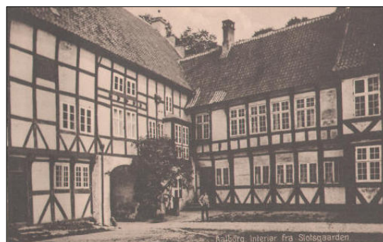
Ålborg Interiør fra Slotsgården
